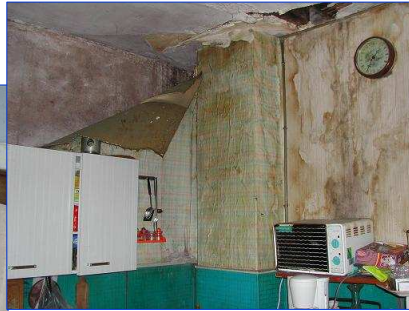
Infiltration d'eau
