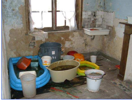
Infiltration d'eau
